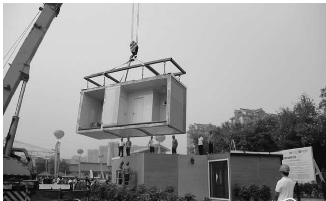
Строительный кран опускает на площадку одну из комнат, предварительно напечатанных на 3d-принтере.
