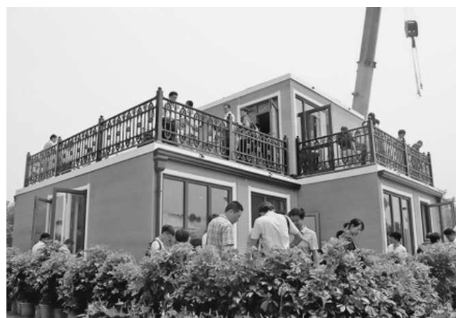
Сборка дома, собранного в китайском городе Сиань из 3d-модулей за 3 часа.
