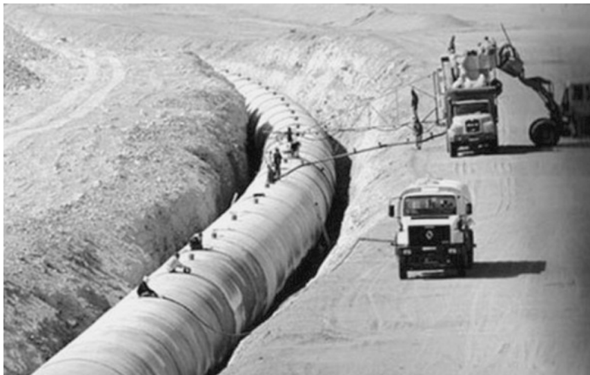
Ливия. Строительство Великой искусственной реки.
