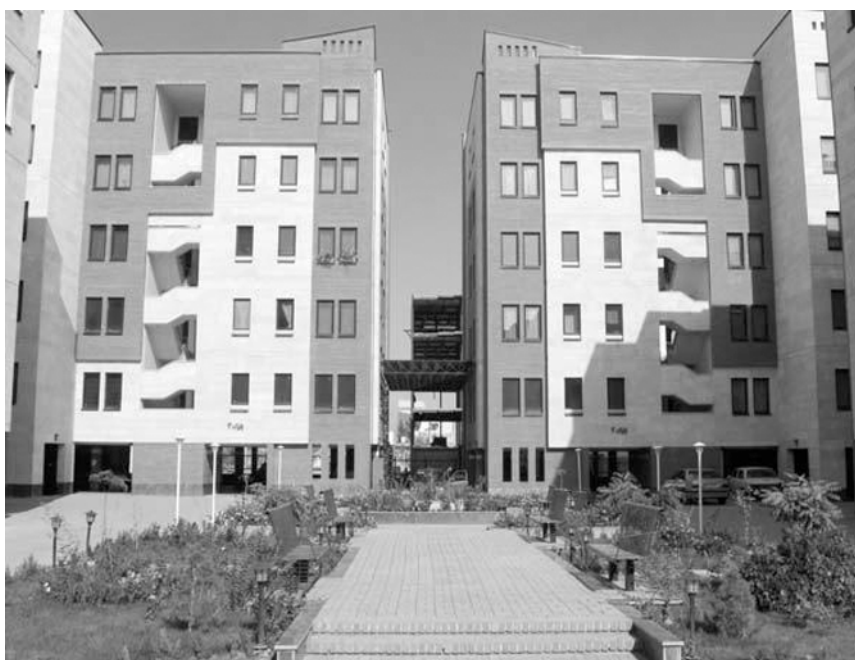
Квартал новых домов, построенных по программе «Мехр» (Iran Daily, 12.08.2010).
