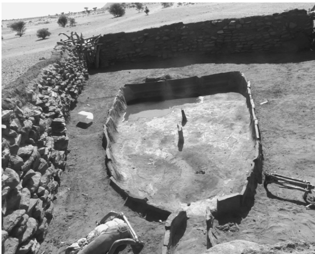
Такие небольшие хафиры для хранения воды строят с использованием современных материалов суданские крестьяне вблизи своих деревень.
