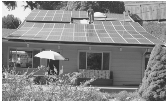
Солнечные батареи на жилом доме.
