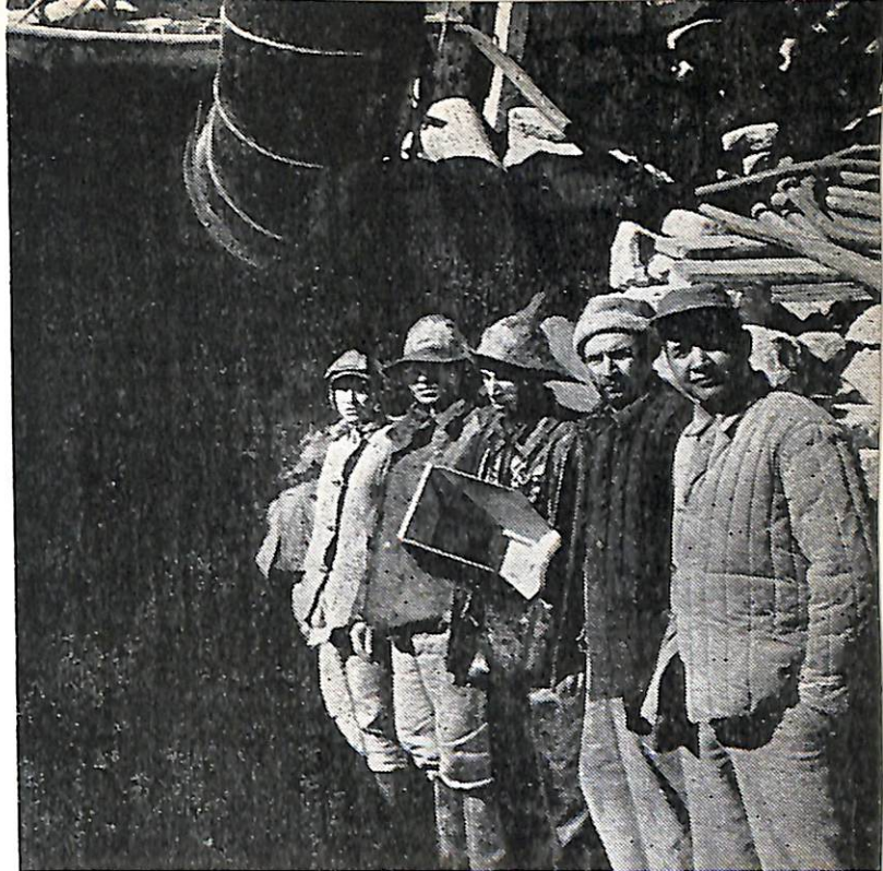
Прочная дружба связывает советских и афганских строителей, прокладывающих высокогорную автомагистраль через Гиндукуш.
