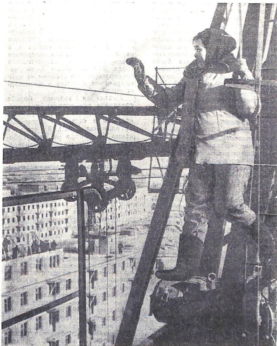
На строительстве крупнопанельных домов в Улан-Баторе.
