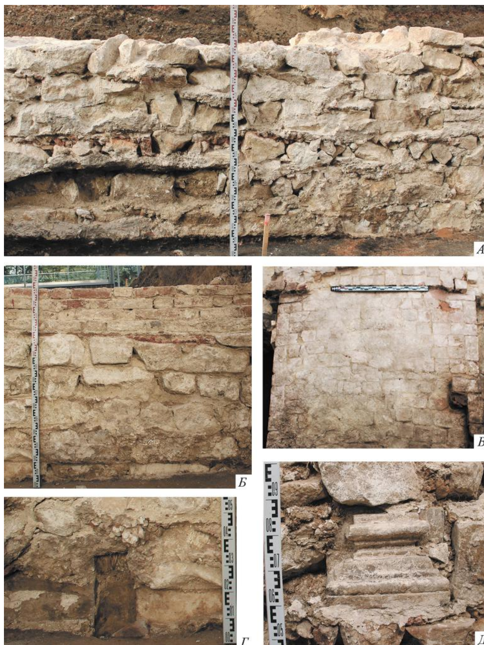
Рис. 5. Фундаменты Новых Приказов: А — кладка фундамента северной стены (вид с Ю); Б — кирпичная кладка стены поверх белокаменной кладки фундамента (вид с З); В — кирпичная кладка стены (вид сверху с Ю); Г — полость от истлевшей сваи в основании фундамента; Д — белокаменный импост в кладке фундамента.
